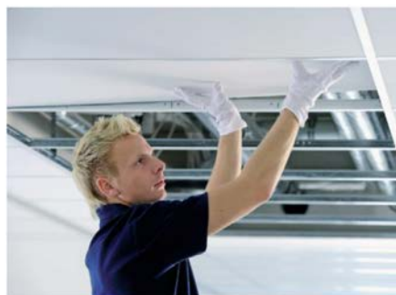
Панели потолочного охлаждения в административной части завода Uponor в Ленинградской области
