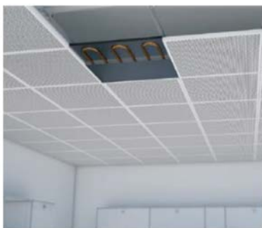
Панели потолочного охлаждения в административной части завода Uponor в Ленинградской области
